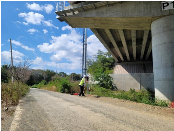
광파기를 이용한 측량 작업사진
